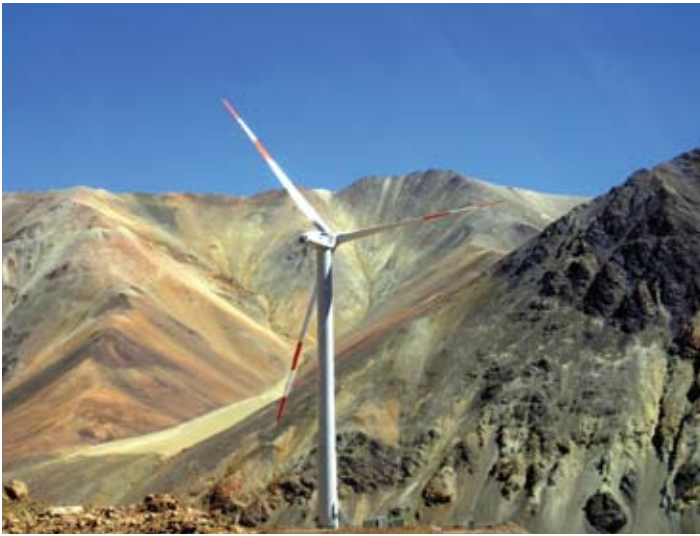
Energía Eólica Renovable. Instalamos un generador eólico de 2 megawatts cerca de la mina Veladero en Argentina y estamos desarrollando un parque eólico de 36 megawatts en Chile.
